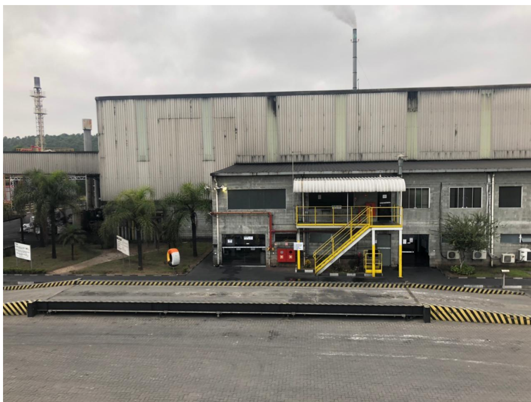
Figura 9 - Transporte de material
